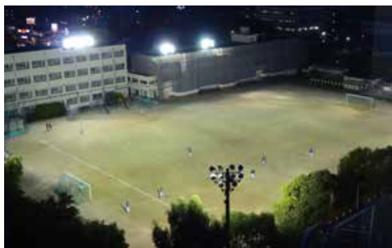
▲地域に開かれたスポーツ施設としての機能が期待される学校施設
